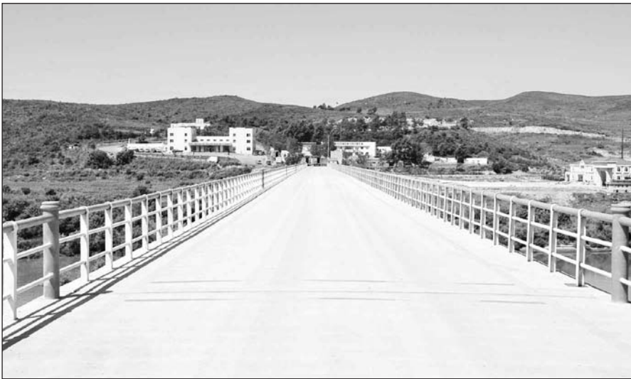
훈춘 권하 통상구와 북한 함북 은덕군 원정리를 잇는 다리. 차량으로 이 다리를 건너 1시간 정도 들어가면 북한 나진-선봉지구가 나온다. <사진 전태극 전 속초민예총 지부장>
